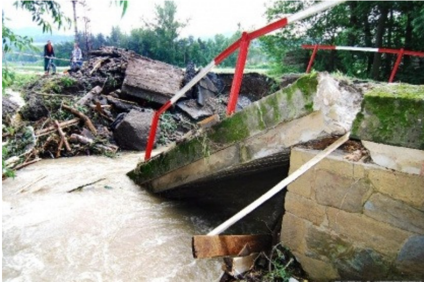
Figura 1.5. Pod distrus de inundații
