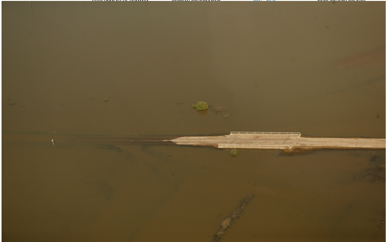
Figura 1.3. Șosea distrusă de inundații
